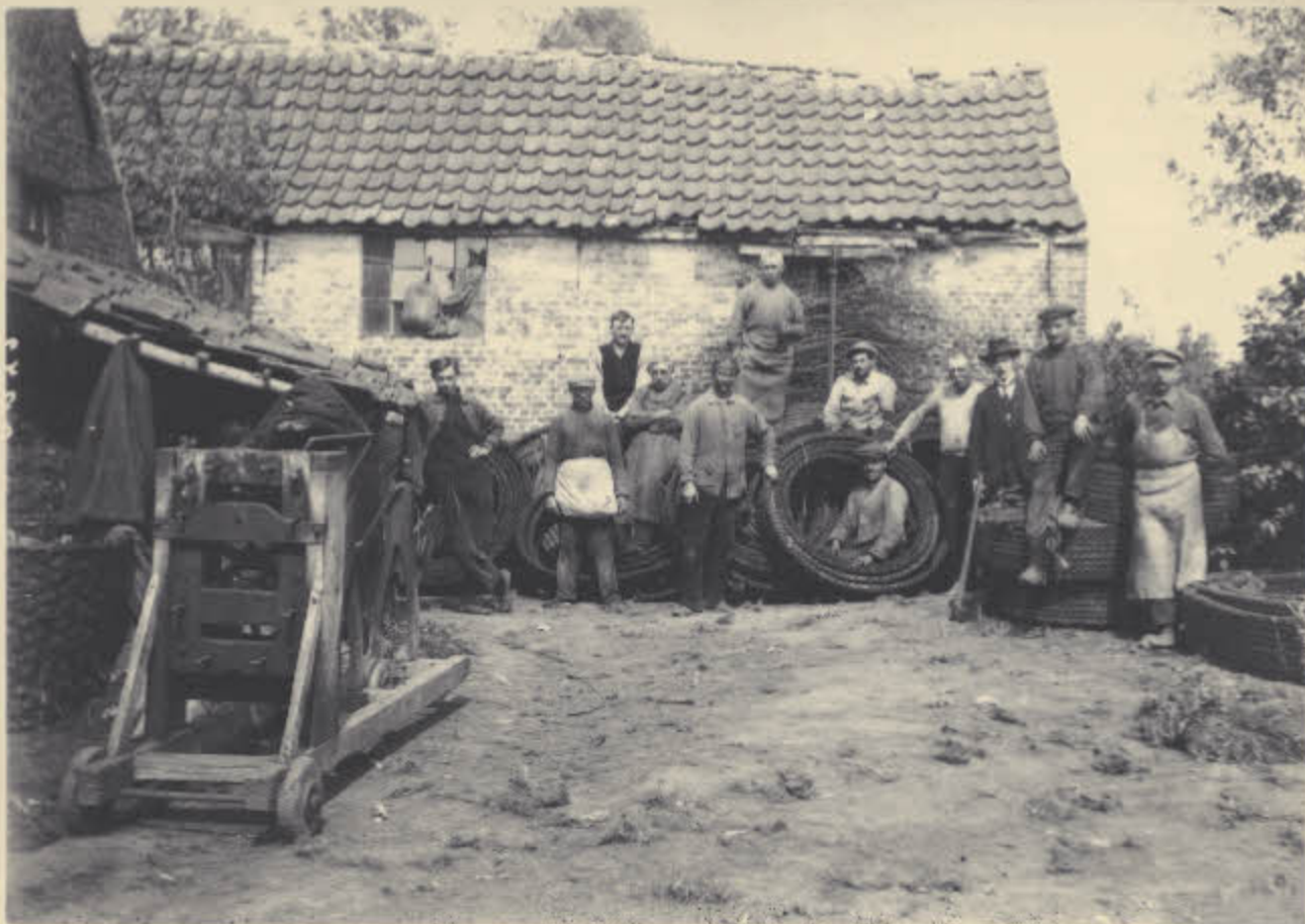
66. Foto gemaakt voor 1914 bij Van Haute - Vercauteren Loskappen van oude mijnkabels om de binnengarens te hergebruiken voor platte kabels Links staat een oude baankar
